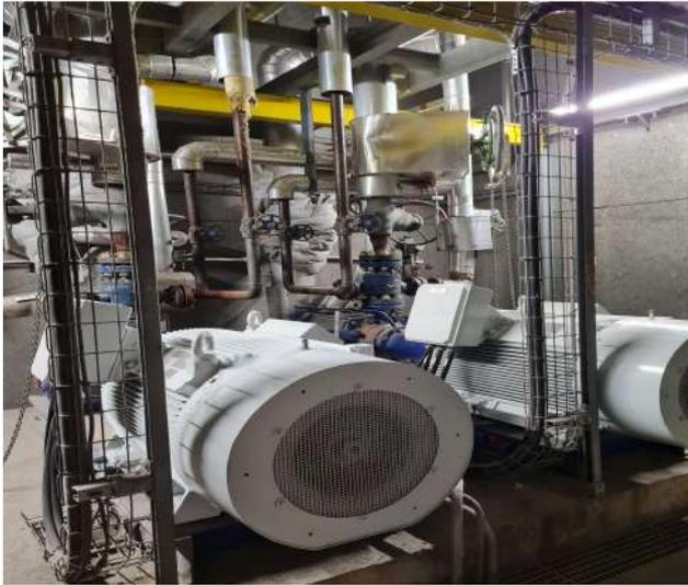
Remplacement d'une pompe condensats par une neuve
