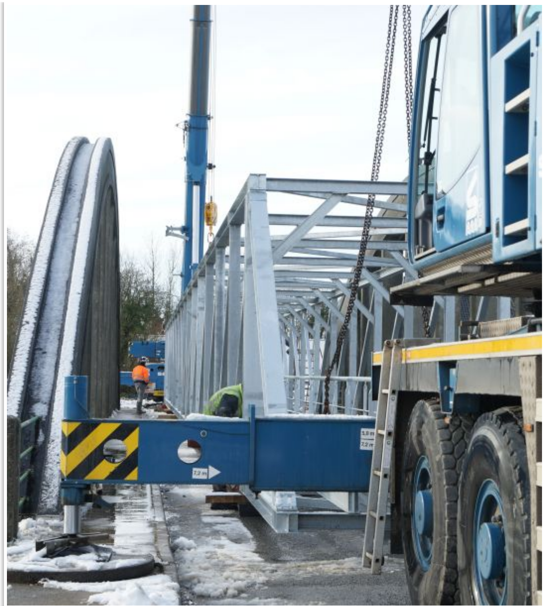
Un «rack», sorte de passerelle, a été installé au dessus du canal de Neufossée, mercredi matin. PHOTO Ph.H. (CLP)
